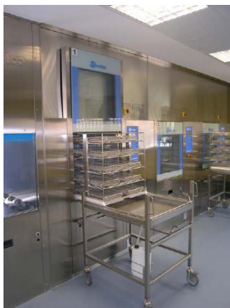
Figura 6. Carga de bandejas de la lavadora automática.
