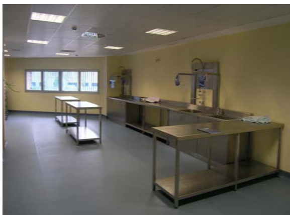
Figura 2. Lavado manual con dos estaciones ergonómicas de lavado y ultrasonidos, con pantalla antisalpicaduras y pistolas suspendidas de aire-agua.
