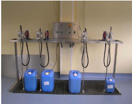
Figura 1. Central dosificadora de detergentes sobre foso de seguridad, para la alimentación de lavadoras automatizadas.
